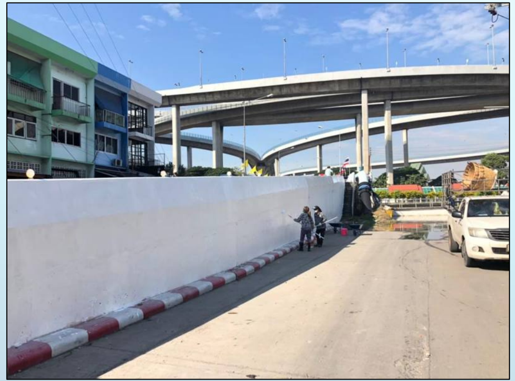
ซ่อมแซมสะพาน ค.ส.ล. ข้ามคลองลาดโพธิ์
