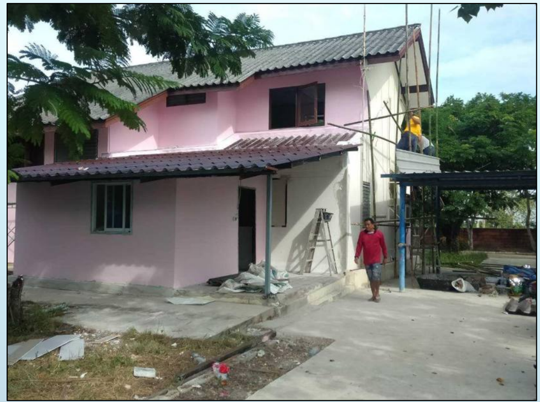
ซ่อมแซมบ้านพักข้าราชการระดับ 7-8 เลขที่ 367/8 จำนวน 1 หลัง
